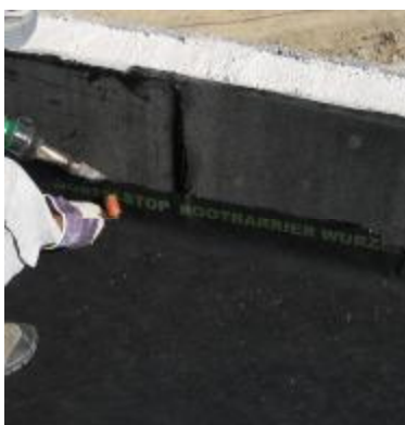
Obr.1 Vytiahnutie fólie 50 mm na vertikálnu plochu Obr.2 Roh pásu šikmo zrezať (45°) (T – spoj)
