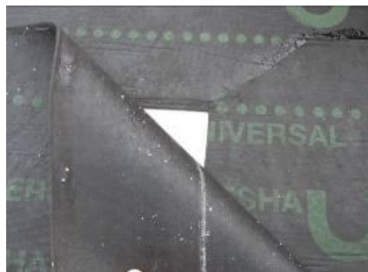
Obr.1 Vytiahnutie fólie 50 mm na vertikálnu plochu Obr.2 Roh pásu šikmo zrezať (45°) (T – spoj)
