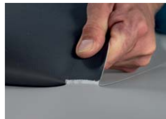
Obr. 12. Vykonávanie testu zvaru.
