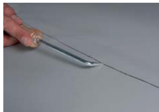
Obr. 15. Kontrola zvaru skúšobnou ihlou.
