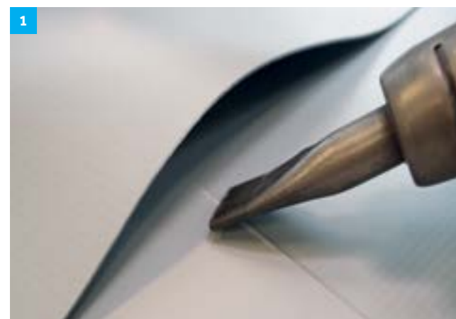
Obr. 15. Kontrola zvaru skúšobnou ihlou.
