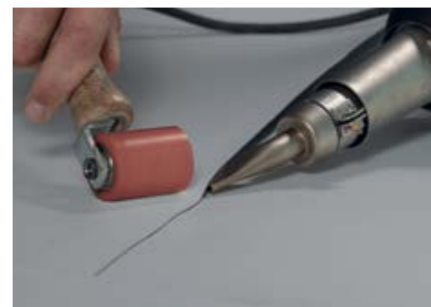
Obr. 13. Zváranie fólie s ručným prístrojom a silikónovým valčekom.
